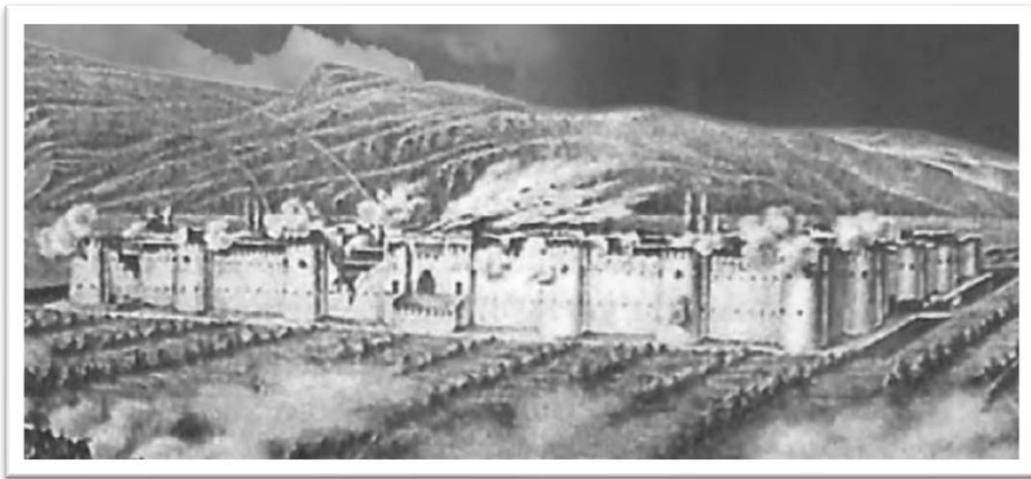
Şəkil3. Sərdarabad qalası
