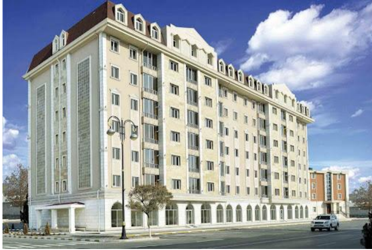
Şəkil 17 . 8 mərtəbəli yaşayış binası. Naxçıvan şəhər Atatürk küçəsi
