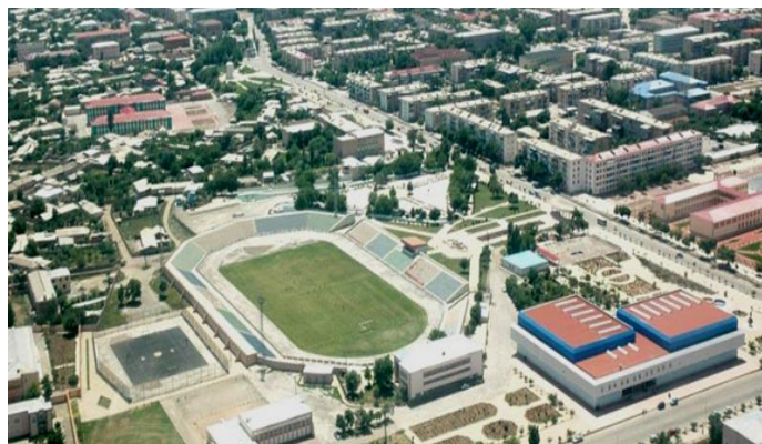
Şəkil 10. Naxçıvan şəhər İdman kompleksi bərpadan sonra
