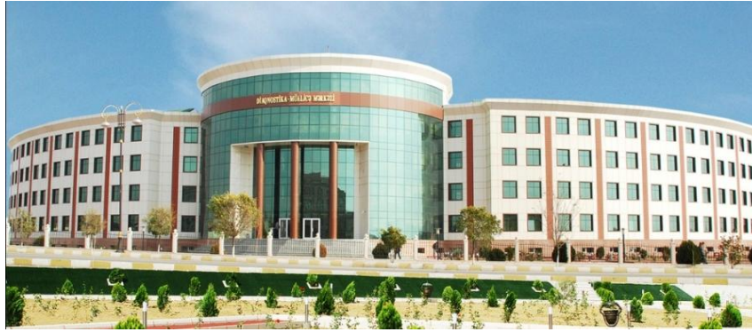
Şəkil 9. Naxçıvan Diaqnostika-Müalicə Mərkəzi binası Naxçıvan şəhər. Ə. Əliyev xiyabanı. 2006-cı il
