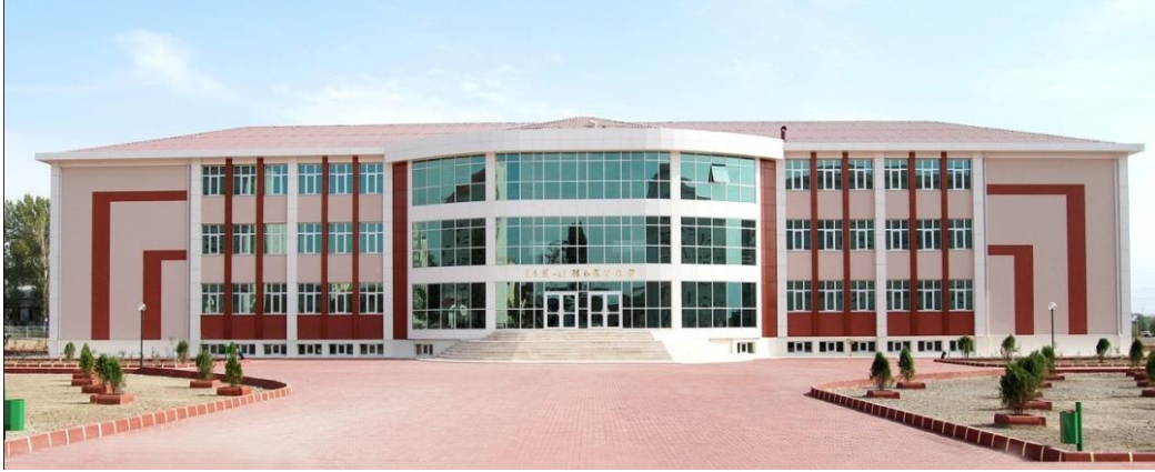
Şəkil 15. 14 nömrəli tam orta məktəb. Naxçıvan şəhəri
