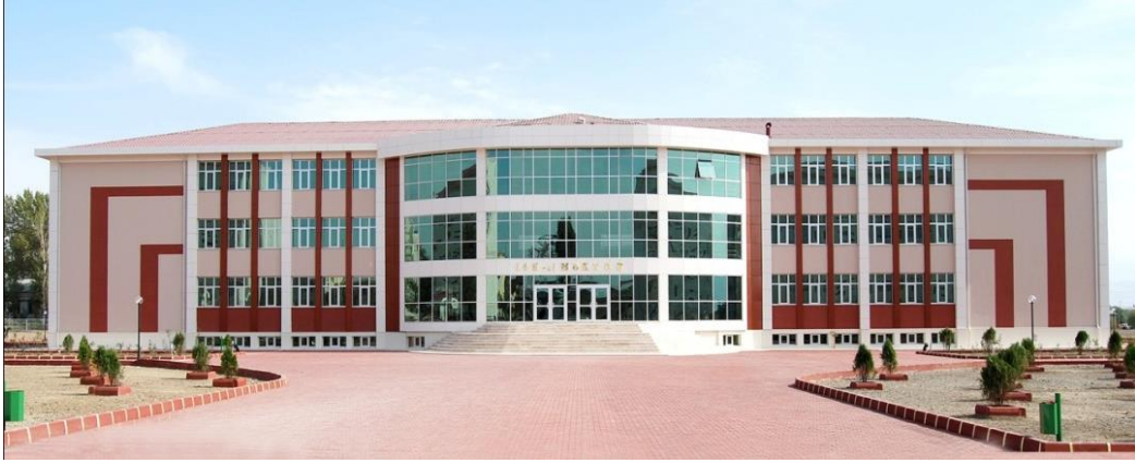
Şəkil 15. 14 nömrəli tam orta məktəb. Naxçıvan şəhəri
