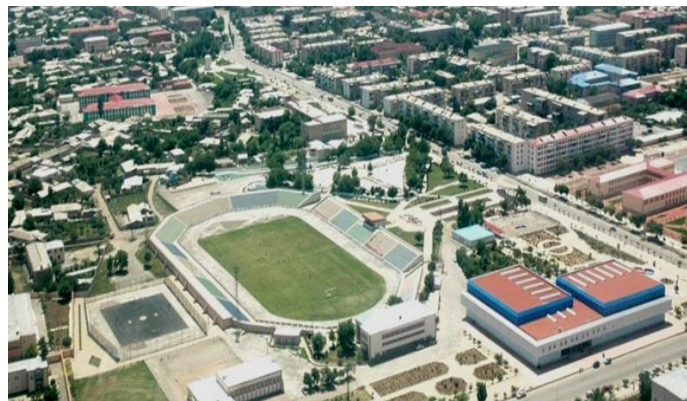
Şəkil 10. Naxçıvan şəhər İdman kompleksi bərpadan sonra
