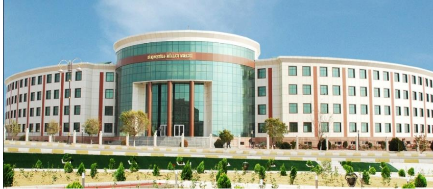
Şəkil 9. Naxçıvan Diaqnostika-Müalicə Mərkəzi binası Naxçıvan şəhər. Ə.Əliyev xiyabanı. 2006-cı il
