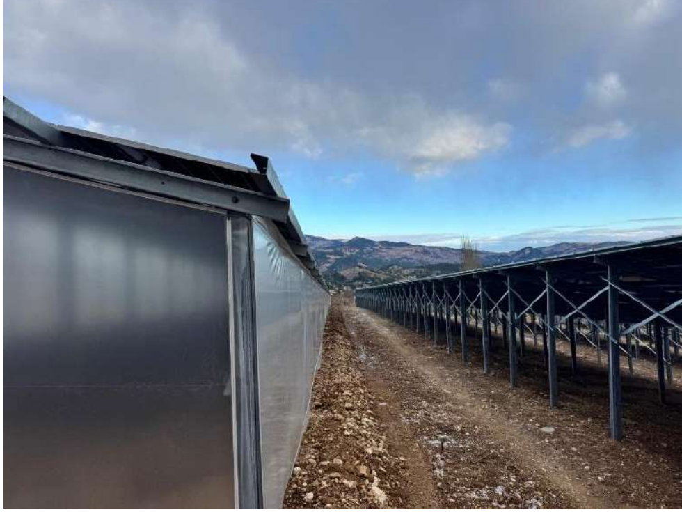
Şekil 3. Bulanık TarımGES Tesisine Ait Görüntü
